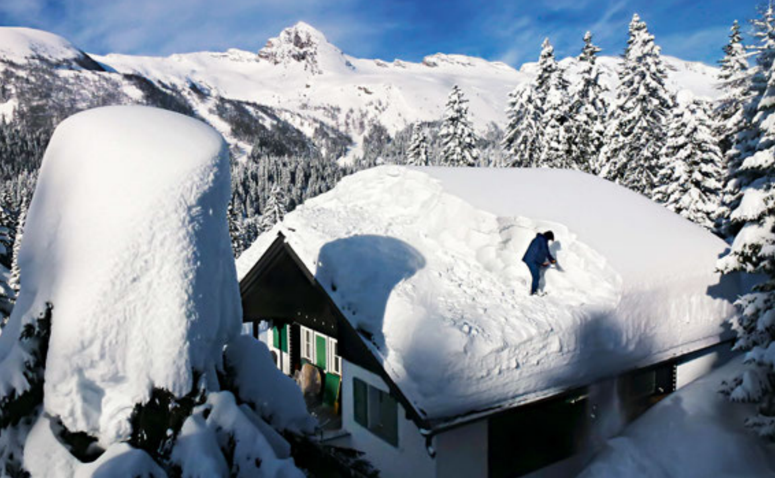
Massive Schneefälle auf der Alpensüdseite: Wie hier in San Bernardino war es im Februar teilweise nötig, die Dächer von den grossen Schneemengen zu befreien. Foto: G. Kappenberger
