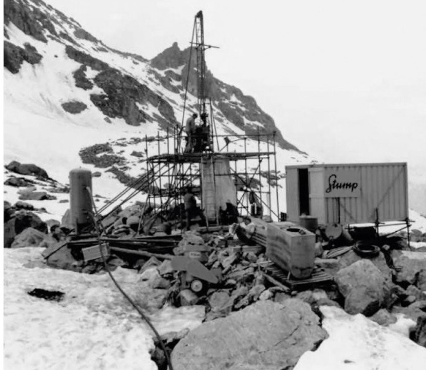
Bohrarbeiten auf dem Blockgletscher Murtèl am Corvatsch zur Installation des ersten Permafrostbohrlochs im Gebirge im Jahr 1987. Foto: Daniel Vonder Mühl
